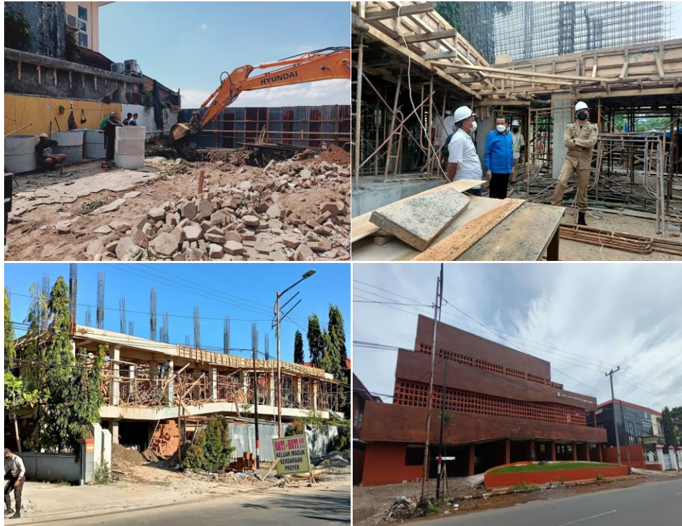
Gambar 3.5 Pembangunan Gedung Layanan Perpustakaan Umum Daerah Tahun 2021
